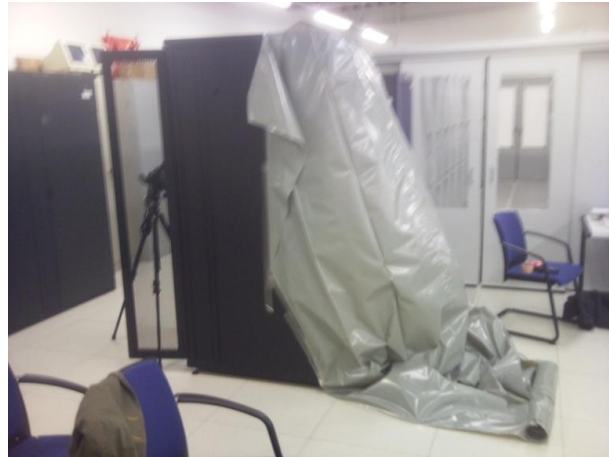
Abbildung 8: Bild der provisorischen schrägen Einhausung
